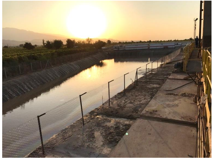
Şekil 2 Geleneksel Çamur Havuzu (Mud-Pit)
